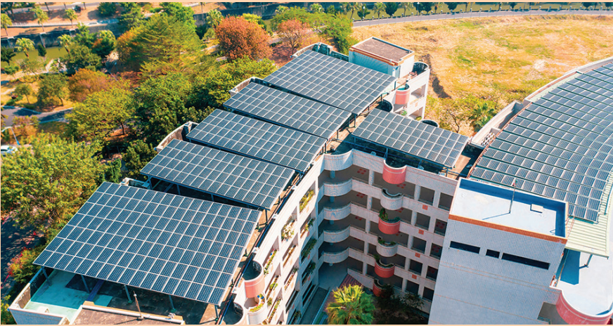
Empresa detida pela britânica Octopus Energy Generation reforça a presença em áreas como hotelaria, logística, retalho alimentar, têxtil e residências séniores.
